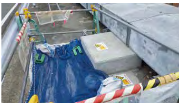
掘削工事現場の状況 (R6.6.28)
