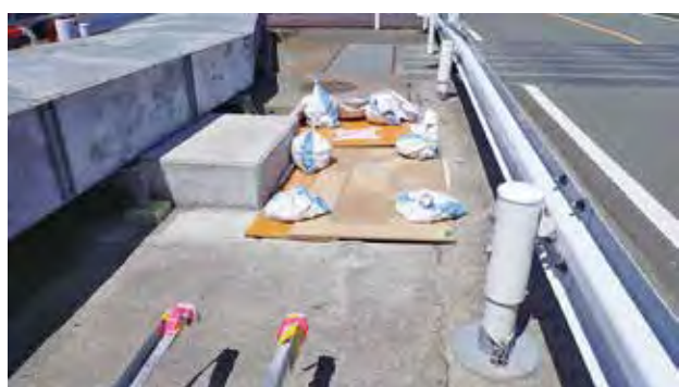
掘削工事現場の状況 (R6.4.25)
