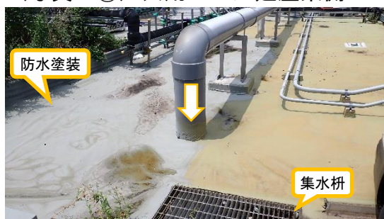
(写真 4 ③) 共用プール建屋南側
