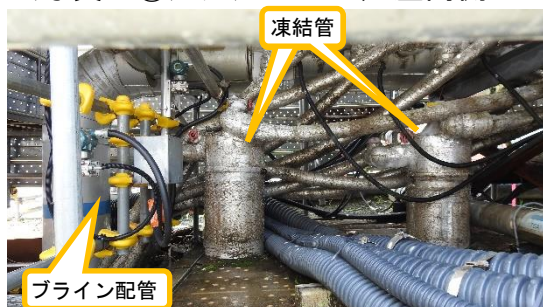
(写真 5 ②) 測温管周辺の凍結管の状況
