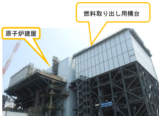
(写真 2 ①) 2号機原子炉建屋西側
