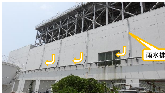
(写真 4 ①) 共用プール建屋東側
