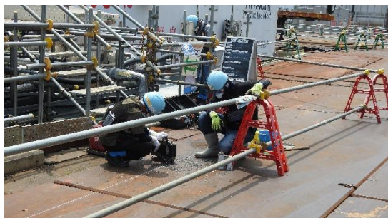
(写真 3 ①) フェーシング工事の状況
