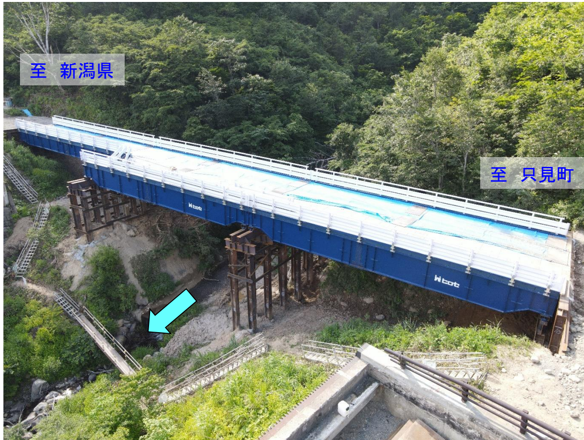
仮橋工の架設完了
