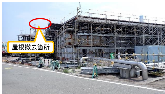
(写真5－1) 屋根の撤去状況
