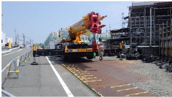
(写真4) クレーンの設置状況
