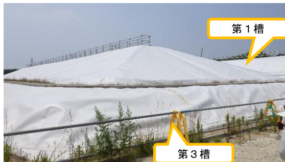
(写真3－2) 第1槽及び第3槽の状況
