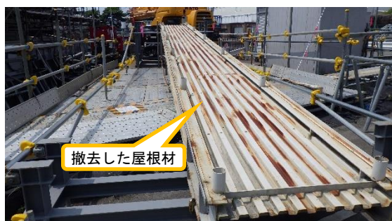
(写真5－2) 屋根材の仮置き状況
