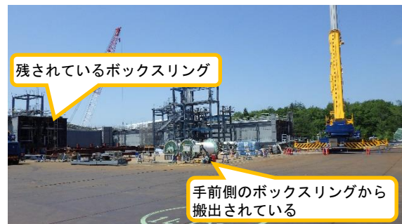
(写真6-1) ボックスリングの搬出状況 (4割程が構外ヤードから構内に搬出済。)
