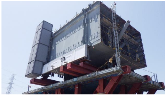
（写真６－２）構内に搬入予定のボックスリングの一部
