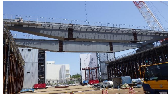
（写真７－１）ガレキ撤去用天井クレーンの地組状況①
