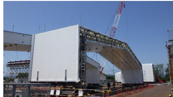
(写真5-1) 可動屋根の保管状況
