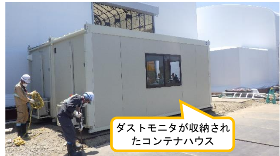
(写真1-2) ダストモニタの設置状況② (撮影日: 令和7年6月20日)
