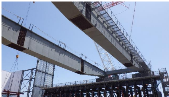
（写真７－２）ガレキ撤去用天井クレーンの地組状況②
