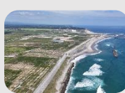
造成された海岸防災林（浪江町）
