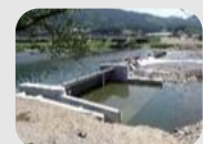
頭首工の改修（埴町伊香堰）
