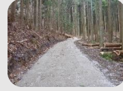
森林作業道 の開設
