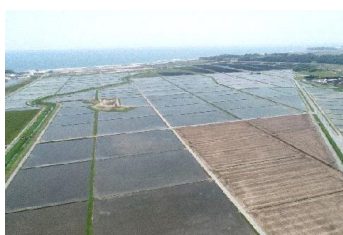
整備後のほ場（南相馬市）
