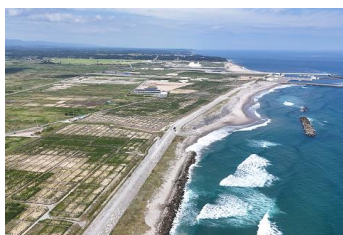
造成された海岸防災林（浪江町）
