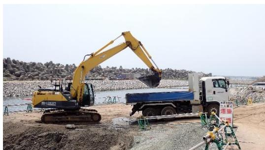
(写真3②) 捨石マウンドの積み込み
