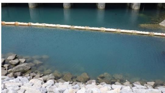
(写真4) 汚濁拡散防止フェンス
