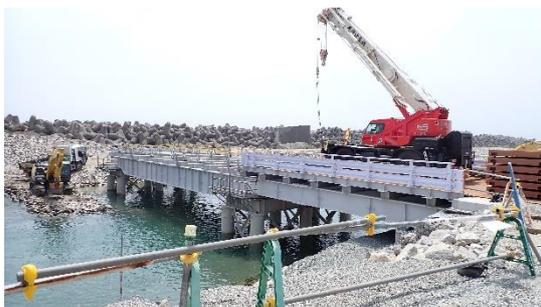
(写真1①) 栈橋の設置工事
