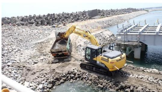
(写真2②) 土砂の積み込み
