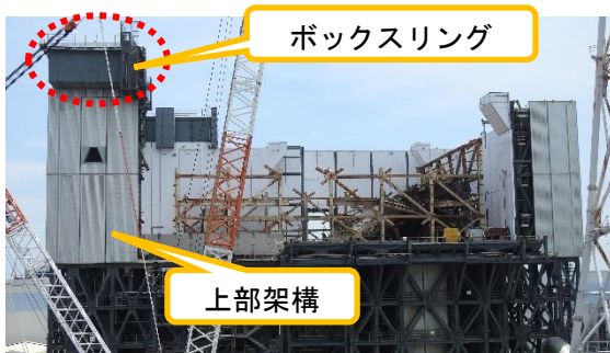
(写真 3 - 1) 原子炉建屋西面外周鉄骨一部撤去後 の状況 (令和 6 年 1 2 月 1 1 日撮影)
