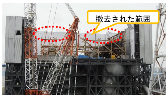
(写真 3 - 2) 原子炉建屋西面外周鉄骨一部撤去後 の状況 (令和 7 年 4 月 3 日撮影)
