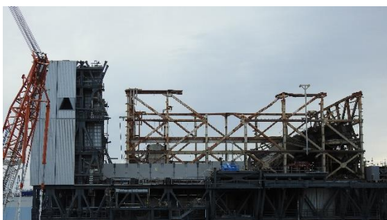
(写真 3 - 1) 原子炉建屋西面外周鉄骨一部撤去後 の状況 (令和 6 年 1 2 月 1 1 日撮影)
