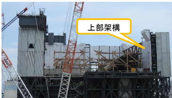
(写真5) 原子炉建屋周囲全体に対する上部架 構の設置状況
