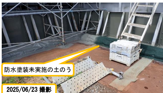
(写真2②)土のうの設置状況
