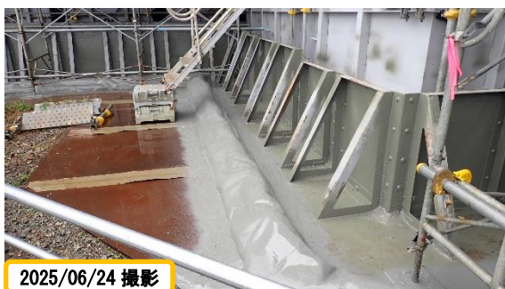
(写真2①)土のうの設置状況
