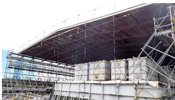
(写真4)建屋の固定状況
