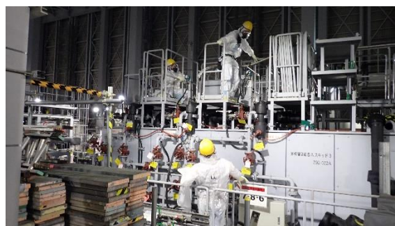
(写真8③) 吸着材の充填
