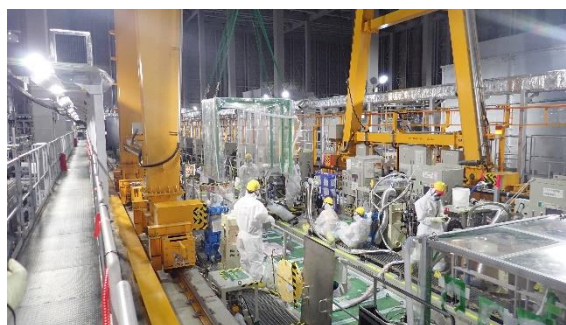
(写真6)クリーンハウスの移設作業
