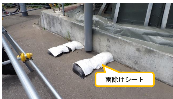
(写真5) 雨除けシートの敷設状況
