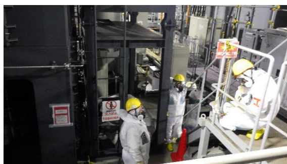
(写真6) 増設ALPSの各設備（反応槽）に おける点検作業の実施状況
