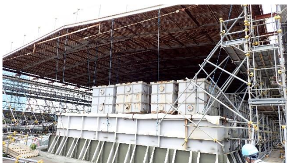
(写真 1－2) 一時保管エリアNの外観②
