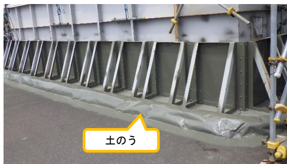
(写真4) 土のうの設置状況 ※土のうに防水塗装が施されている
