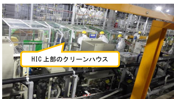
(写真7) 増設ALPSのHIC取り出しに 係るハウス移動準備作業
