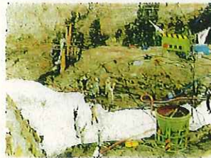
H7.8 コンクリート初打設
