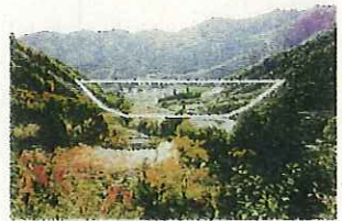
H6.10 ダム本体工事着手前 (上流より下流を望む)
