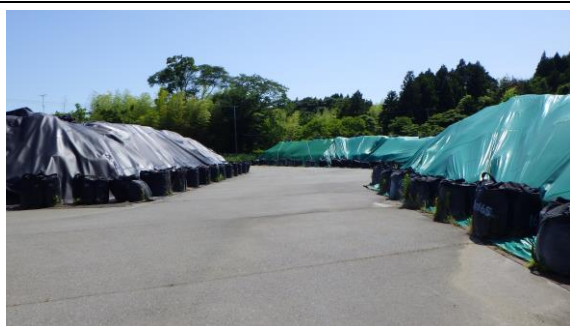
保管状況 異常なし
