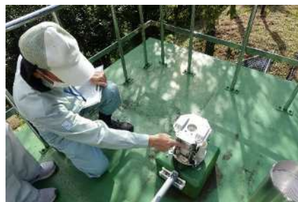
テレメータ局点検（雨量計の清掃）
