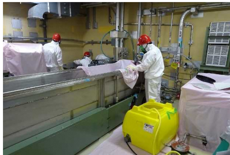
3号炉除染作業
