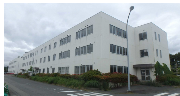
協力企業棟の解体前
