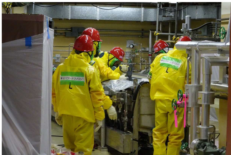
1号炉除染作業
