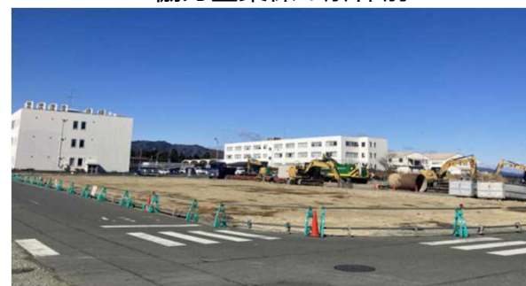
協力企業棟の解体後
