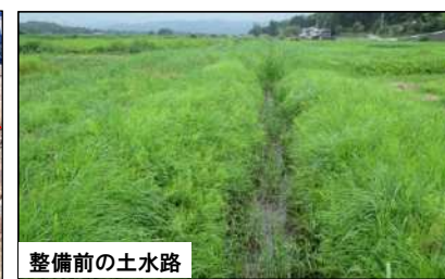
整備前の土水路
