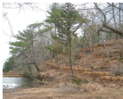
丸太筋工の設置
