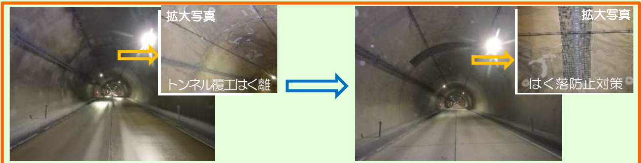
国道401号 喰丸トンネル（昭和村）
