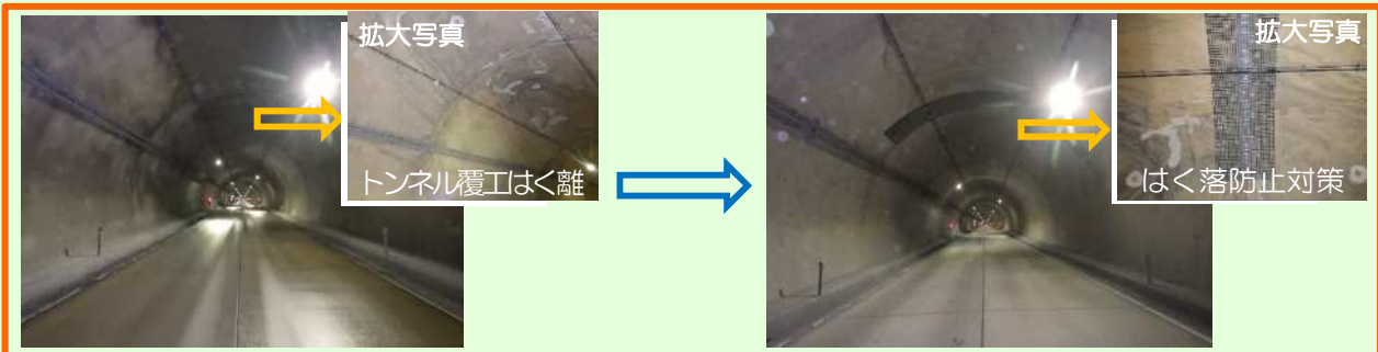
国道401号 喰丸トンネル（昭和村）
