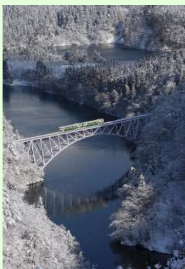
第1只見川橋梁
