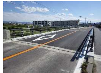
③補修施工を行い完了
