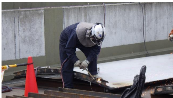
(写真1-3) タンク解体片の溶断作業の状況 (タンク減容ヤード内)
