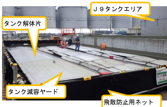
(写真2) タンク減容ヤードの状況
