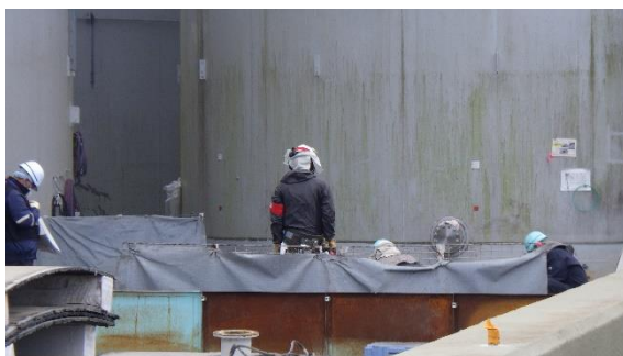
(写真1-4) タンク底板の溶断作業の状況 (J9タンクエリア内)
