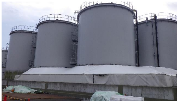
(写真1-1) J9タンクエリア外観
