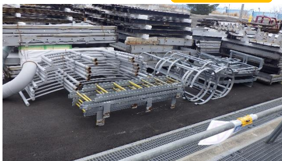
(写真3) 1・2基目の解体片 仮置き場所の状況
