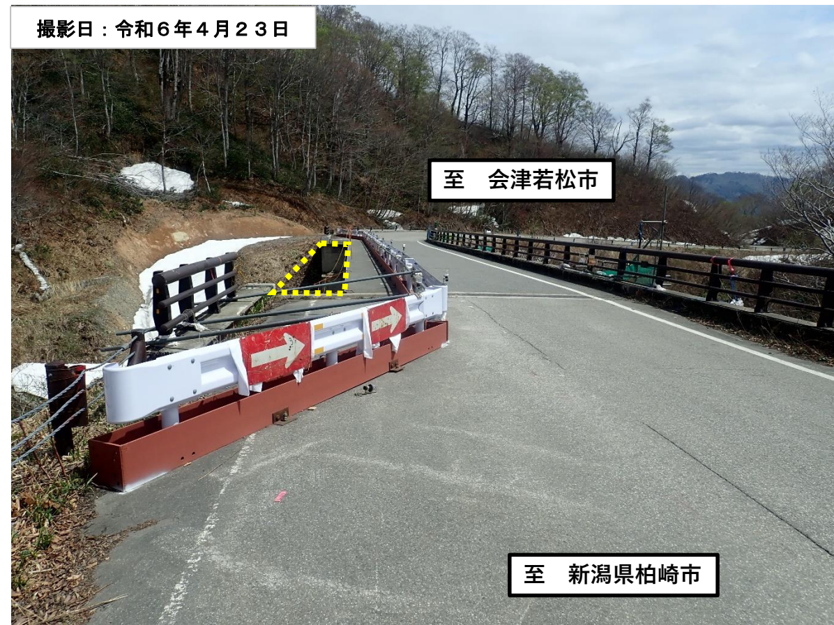
山側の桁1本を撤去し片側交互通行で車両解放
