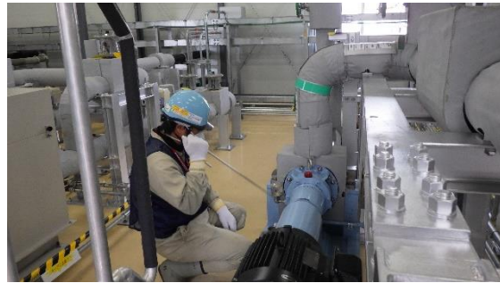
(写真1⑥)ポンプの稼働状況確認
