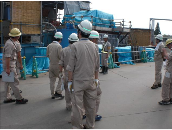
右岸幹線「東小蓋工区（プラント）」
