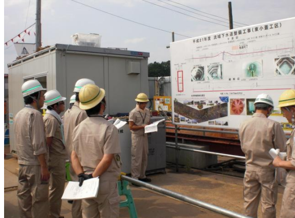
右岸幹線「東小蓋工区」
