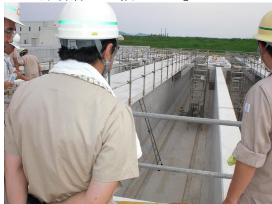
処理場「2系3・4池(土木)」
