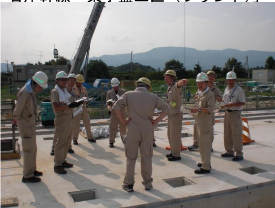
処理場「2系3・4池(土木)」
