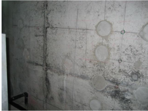
S P棟A 下部耐震補強工事
