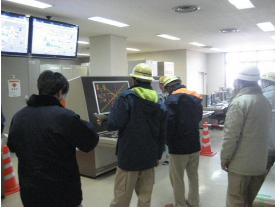
管理棟・中央管理制御施設設備改築更新工事
