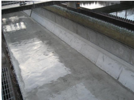
水処理施設改築更新耐震補強工事
