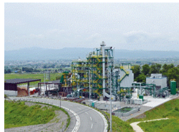
写真：木質バイオマス発電所（提供：㈱グリーン発電会津）
