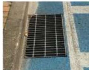
写真Ⅱ-4 マンホールの蓋に滑り止め加工した事例
