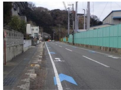
写真 3-2 車道混在（矢羽根）（いわき市）
