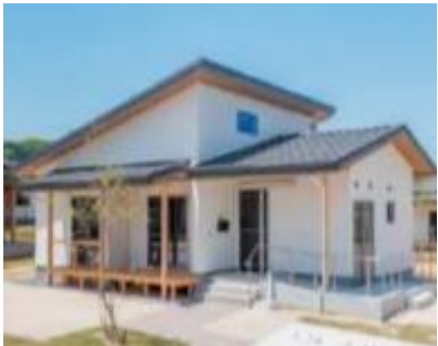
大熊町：災害公営住宅
