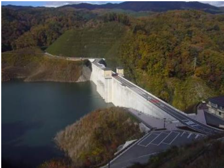
木戸ダム（檜葉町）
