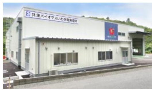
共栄バイオマスいわき南発電所（提供：共栄（株））
