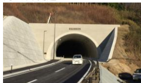
国道114号（川俣町山木屋工区関場トンネル） 2022年12月26日 供用
