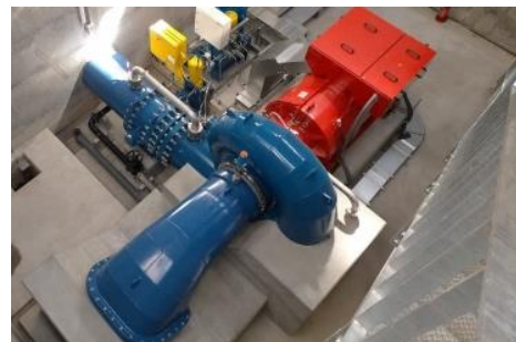
信夫山・光大寺小水力発電所（水車発電機） （信夫山福島電力（株））
