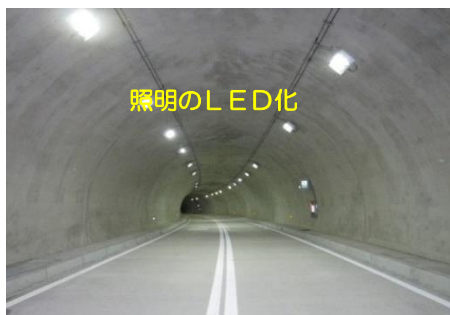
LED 事例 (国道 252 号 滝トンネル (金山町))
