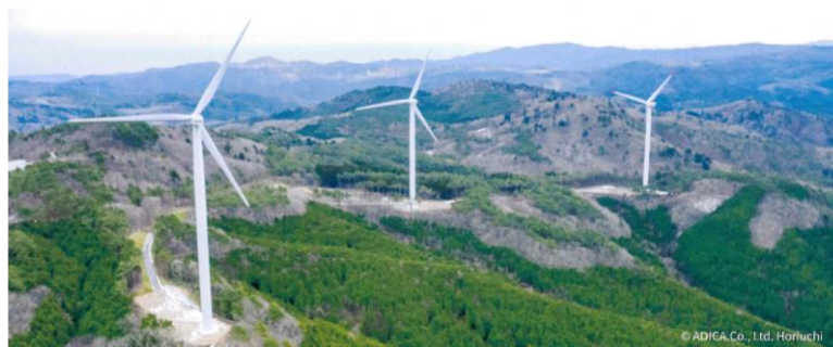
川内風力発電所（川内村）（提供：川内電力株式会社）
