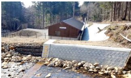
信夫山・遠藤ヶ滝・大玉第一小水力発電所
