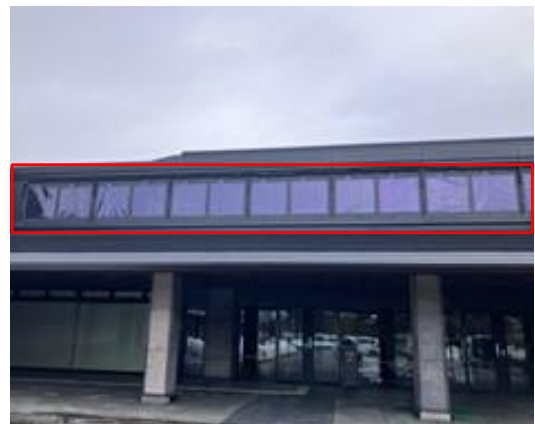
福島県立博物館 正面玄関壁面 （垂直面：40 m 2 ）
