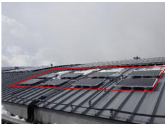
あづま総合運動公園 第1体育館屋根面 （曲面：30 m 2 ）
