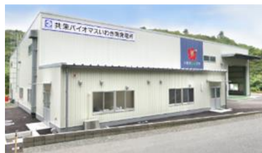
共栄バイオマスいわき南発電所（提供：共栄（株））
