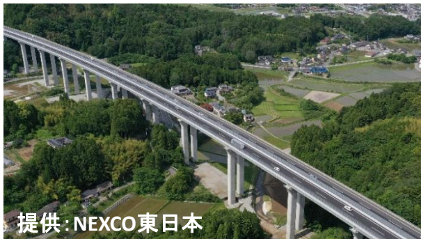
提供：NEXCO東日本 常磐自動車道(いわき中央IC～広野IC) 令和3年6月13日 4車線運用開始
