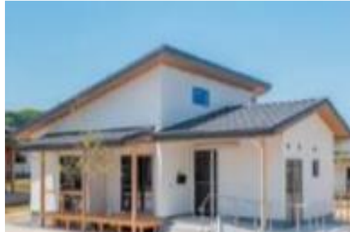
大熊町：災害公営住宅
