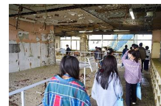
震災遺構浪江町立請戸小学校
