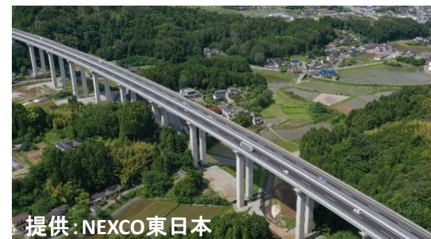
提供：NEXCO東日本 常磐自動車道(いわき中央IC～広野IC) 令和3年6月13日 4車線運用開始
