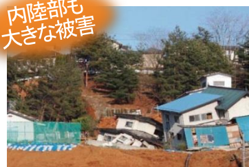
家屋被害の状況 (福島市伏拝地内)
