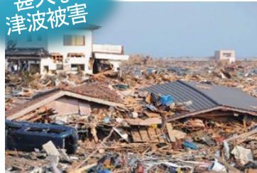
家屋被害の状況 (浪江町請戸地区)
