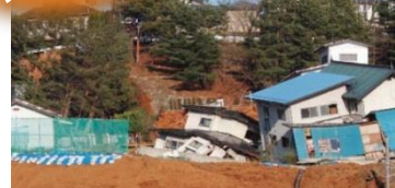
家屋被害の状況（福島市伏拝地内）
