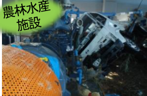
八沢排水機場（相馬市）
