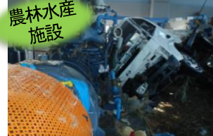
八沢排水機場（相馬市）
