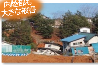
家屋被害の状況（福島市伏拝地内）
