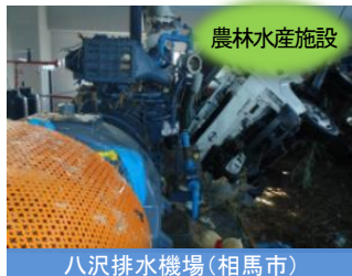
八沢排水機場（相馬市）
