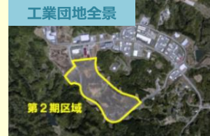
工業団地全景
