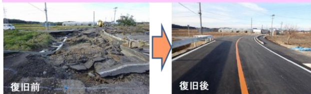
県道母須須賀川線（須賀川市和田地内）
