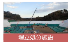
埋立処分施設
