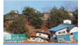
家屋被害：福島市
