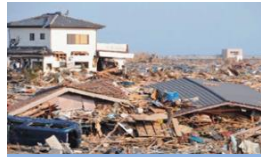
津波被害：浪江町
