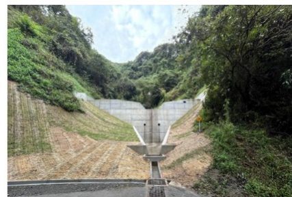
▲ 工事完成写真
