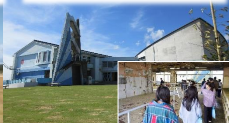
震災遺構浪江町立請戸小学校
