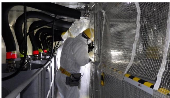
(写真 2) 設備の状態確認の状況
