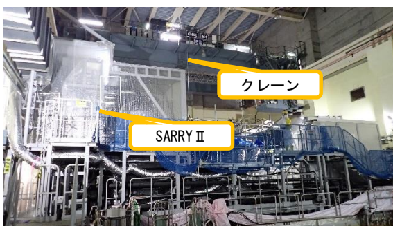
(写真 3—1) 保護ネット設置に向けた準備作業の 状況①
