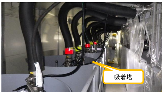
(写真1-2) 吸着塔の状況② ※吸着塔上部から撮影
