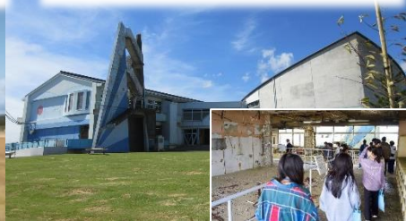
震災遺構浪江町立請戸小学校
