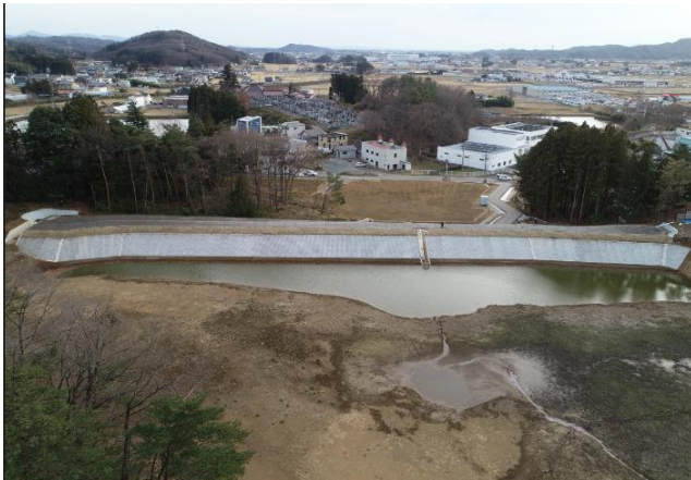
ため池全景（上流側から）
