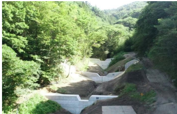
治山施設（治山ダム）施工状況
