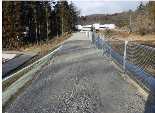
堤体天端部状況（左岸側から）
