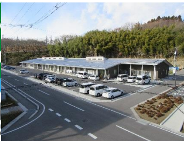
病院 (団地隣接)
