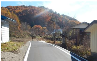
完成した道路の様子→
