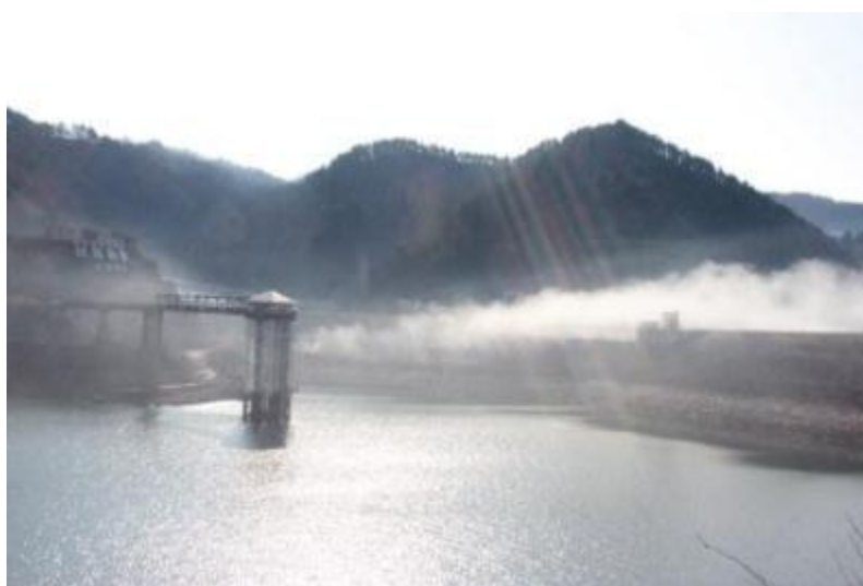
下流よりダム湖に霧が流れ込んできました
