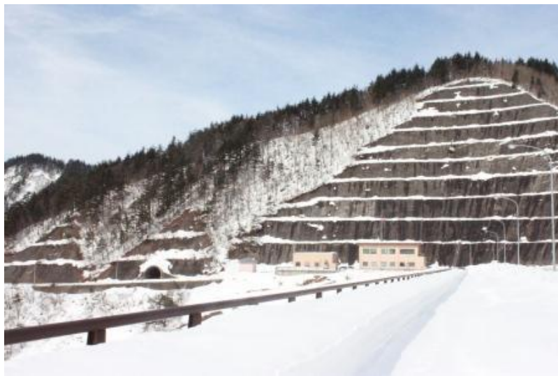
ロマン公園から眺める取水塔と大峠道路
