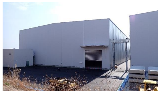
(写真1-2) 第10-C棟の外観② (北西側から撮影) (令和7年2月17日撮影)
