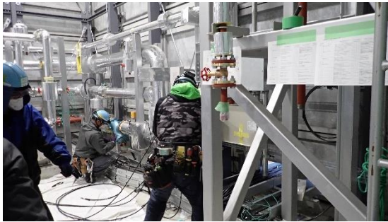
(写真3-2) 給気設備建屋内の状況② ※ケーブルの敷設作業実施中
